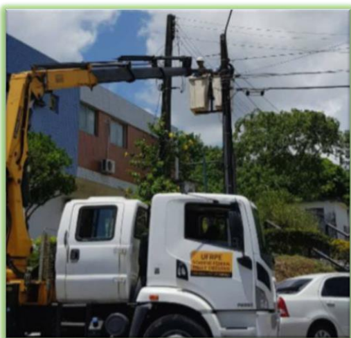
Figure 5- Instalação de lâmpadas tubulares de LED
