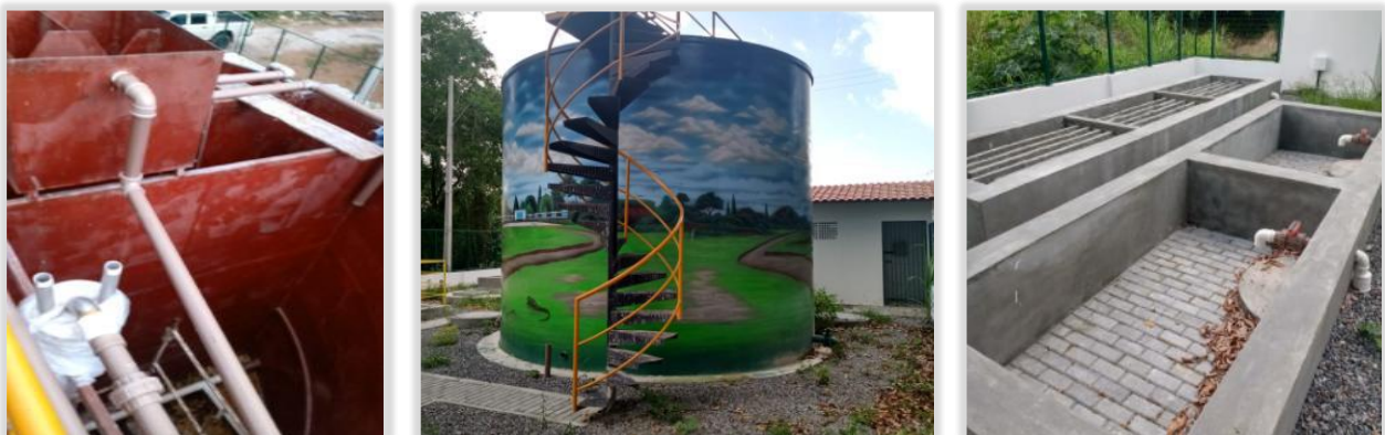
Figure 7- Fotos da nova Estação de Tratamento de Efluentes
